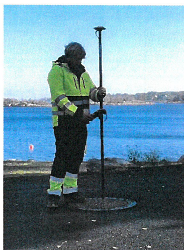
Innmåling av kum for registrering i kommunens ledningsdatabase
